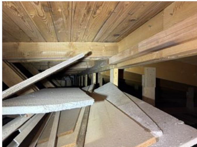
Bilden visar vy av vind.
