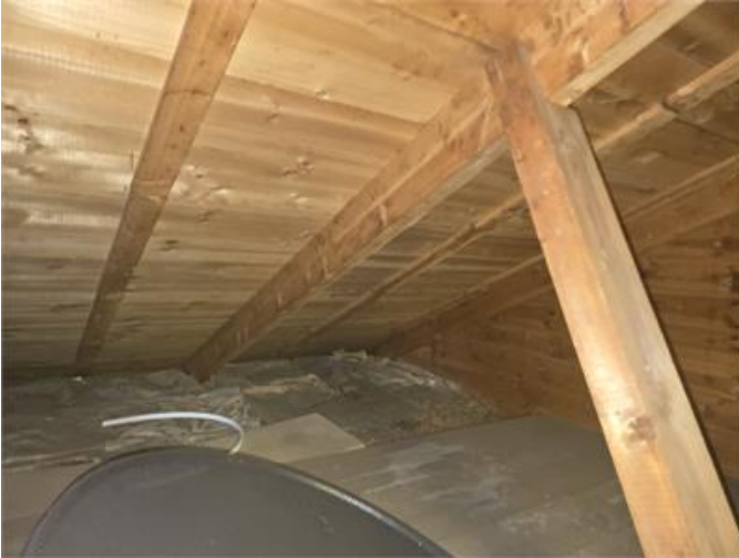
Exempel från del av vinden.
