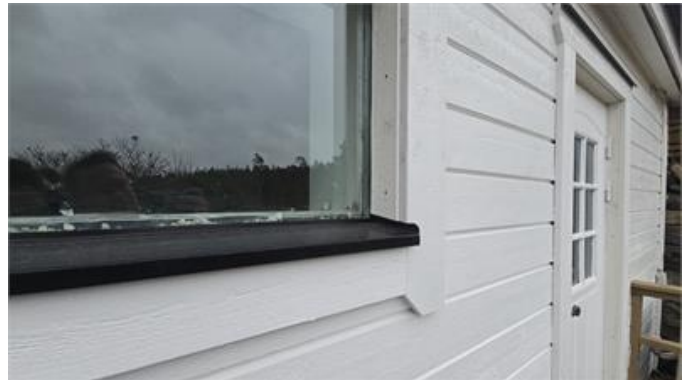
Montage av fönsterkassett källarum.
