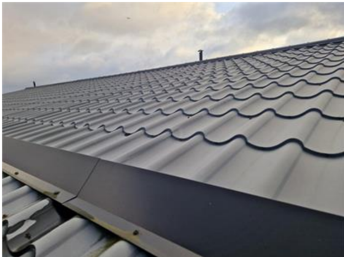
Vy på yttertak
