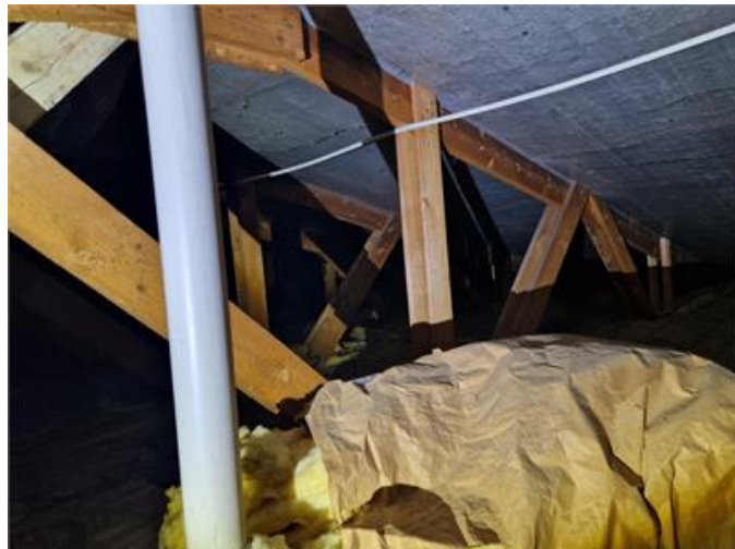
Vy på vindsutrymmet
