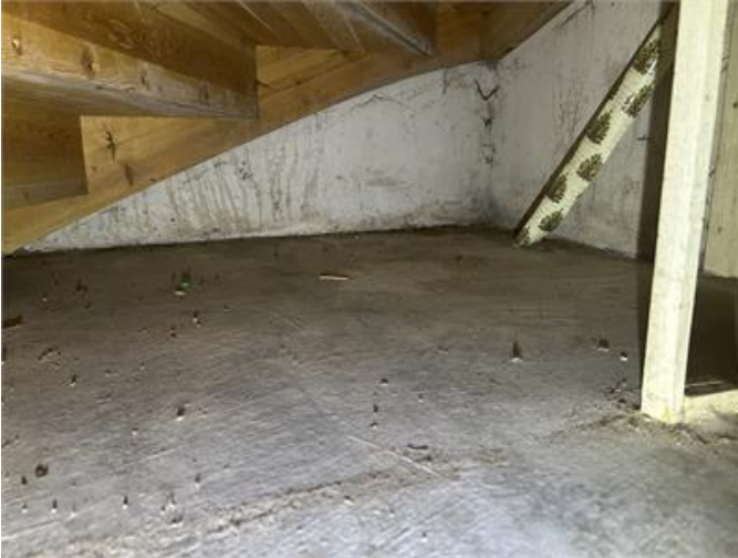
Trappförråd i källarplan: Översiktsbild.
