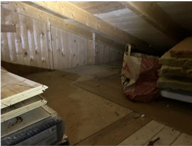
Garage nockvind: Översiktsbild.
