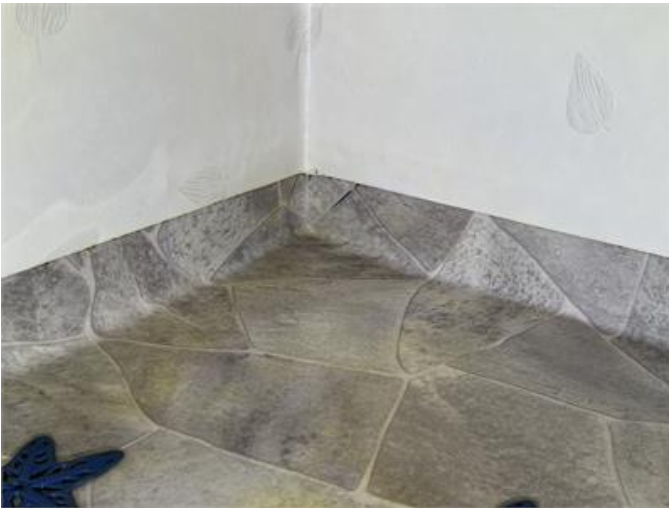
Spricka i ytskitsskarv i dusch på övre plan.
