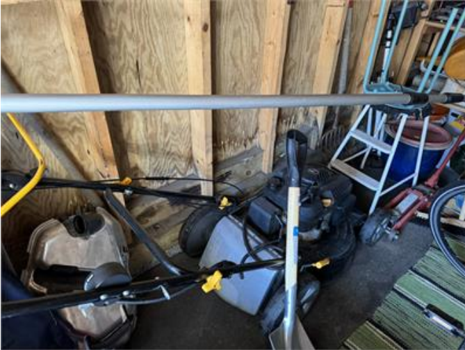
Fuktfläckar på yttervägg i garage.
