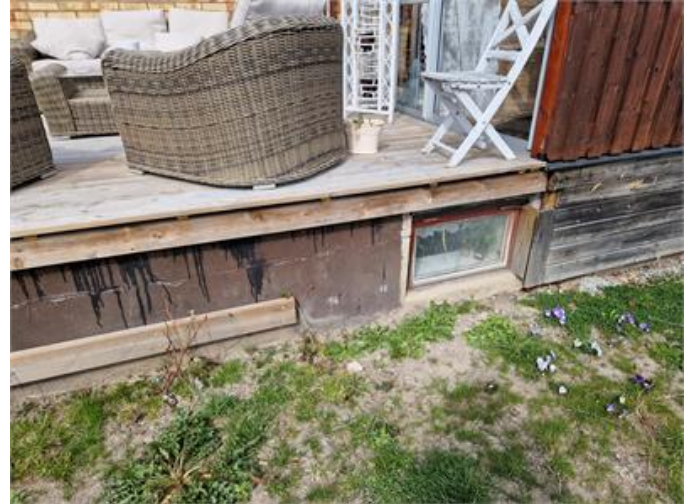
Trappor/Altan/Uterum: Altangolvets tätskikt är ej besiktningsbart (på grund av ovanpåliggande trall/uterum)
