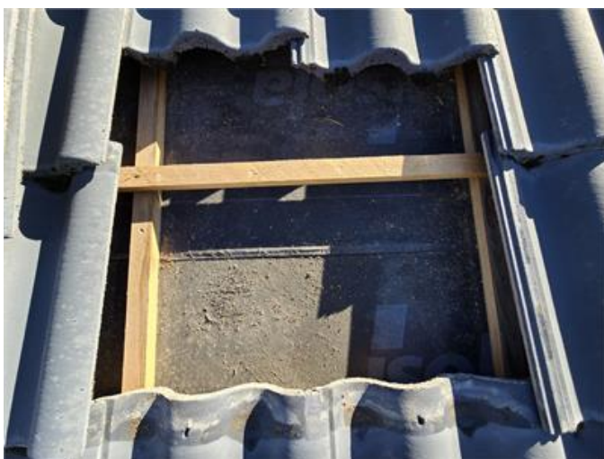
Tak: Stickprovskontroll under pannor.
