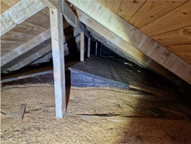
Vind huvudbyggnad: Äldre yttertak finns kvar under det nya.
