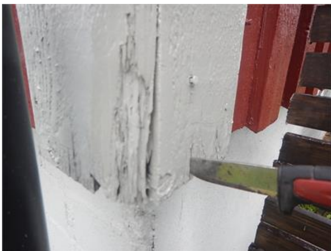
Rötskada knutbräda.
