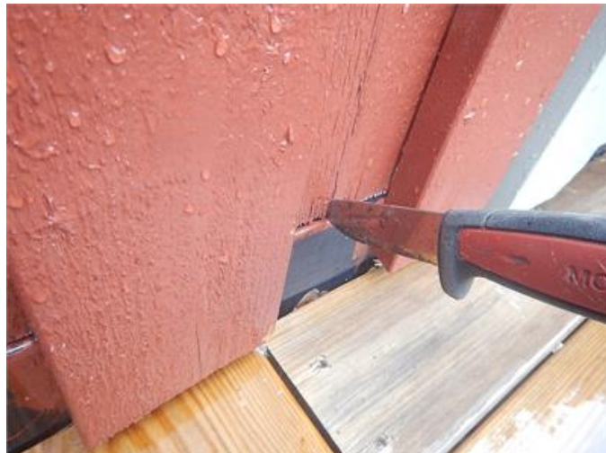
Rötskada fasadpanel.
