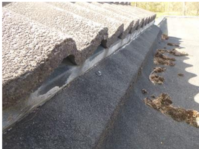
Kort överhäng på pannor mot garagedel samt skruvar dragen genom papp
