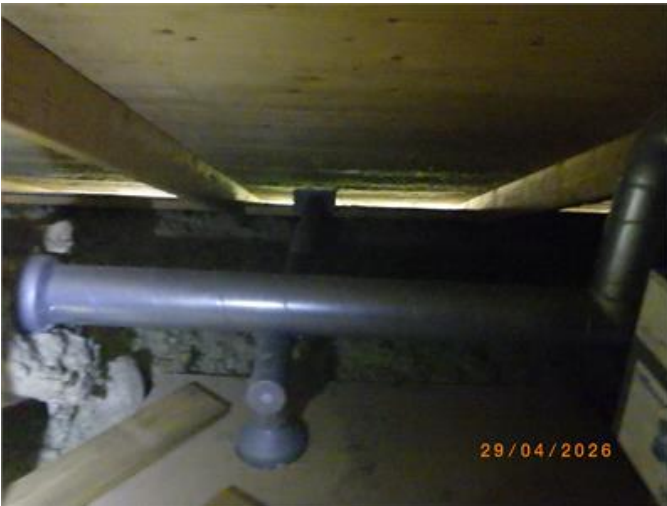
Oisolerade ventilationskanalernockvind.
