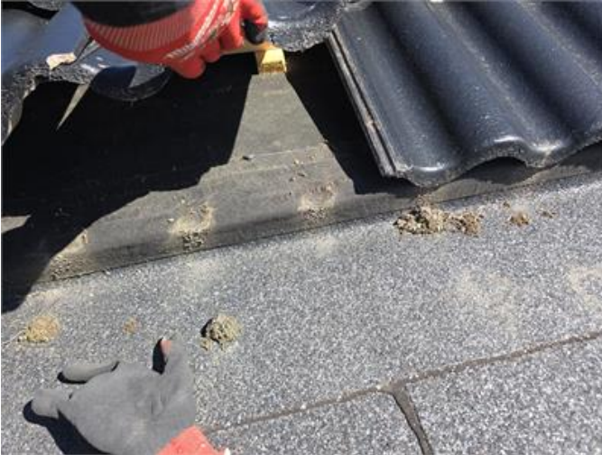
Bilden visar ett exempel på takpannor som ligger an mot papp.
