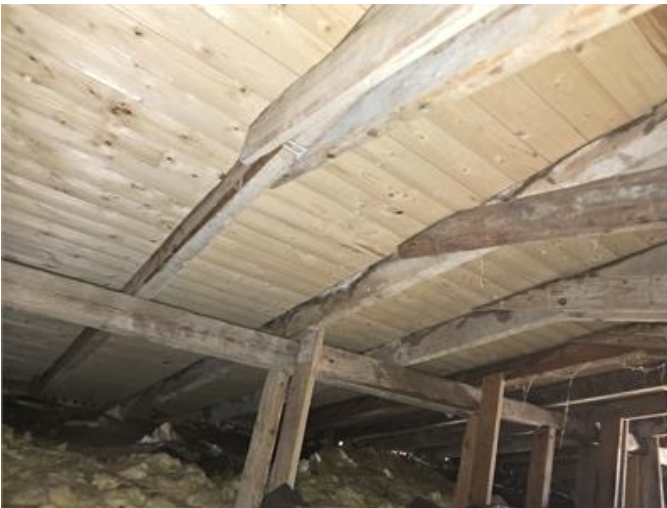
Överblick del av vinden.
