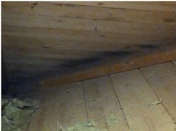
Bild från vindsutrymmet.
