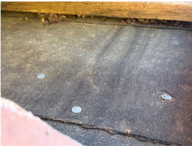
Vid stickprovskontroller av läkt och papp noterades inga skador.
