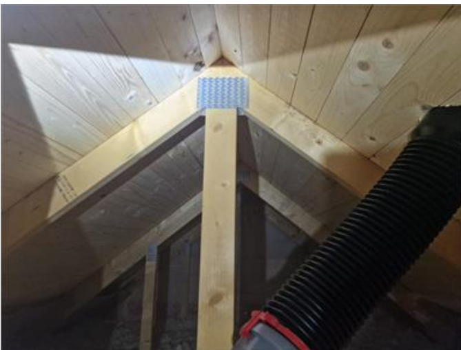
Vy på vindsutrymmet
