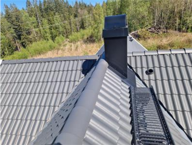
Vy på yttertak
