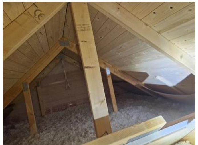
Vy på vindsutrymmet
