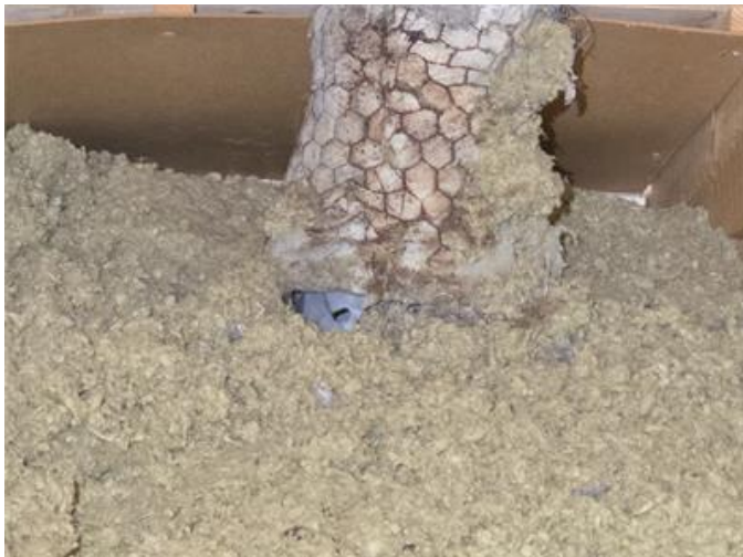
Hål i köksfläktens flexslang
