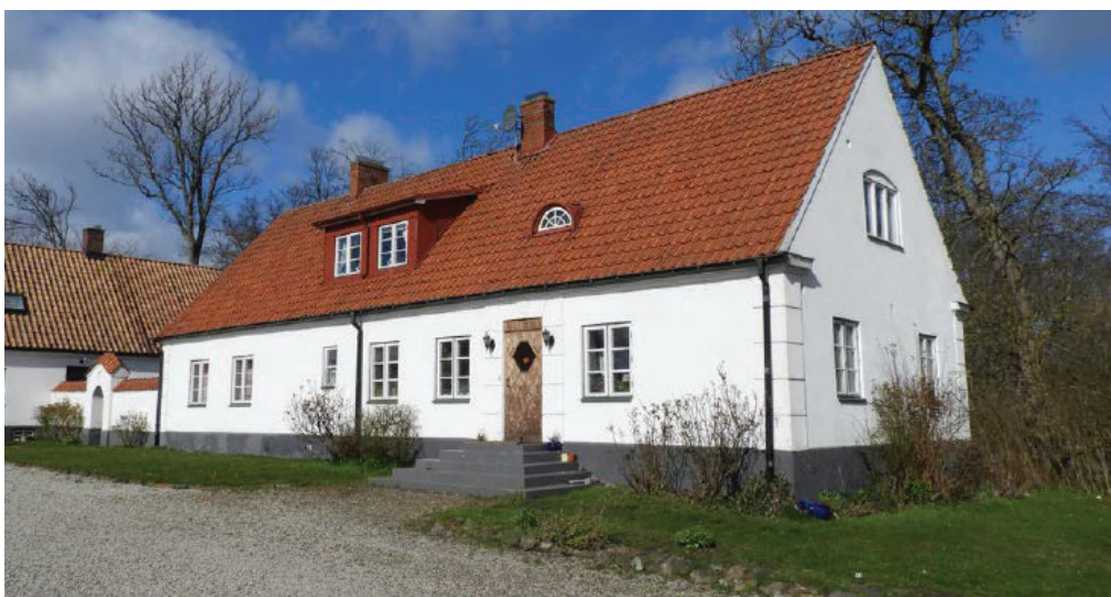
Flygelbyggnaden från söder. Foto: Olga Schlyter
