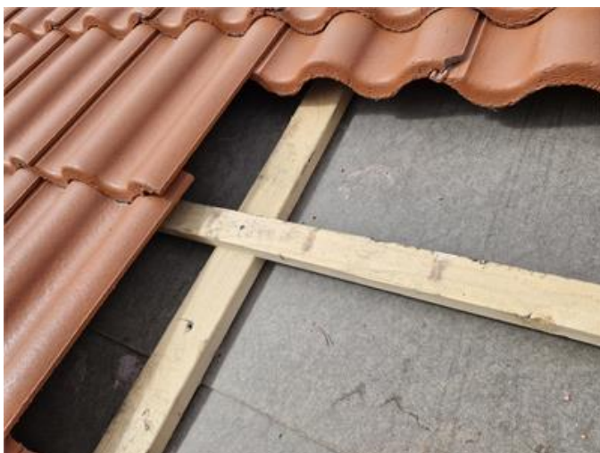
Tak, ursprunglig del har underlagstak av träberskivor.
