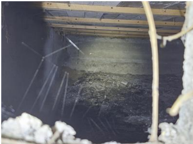
Krypgrund bild via ventil öster, ej åtkomligt för besiktning.
