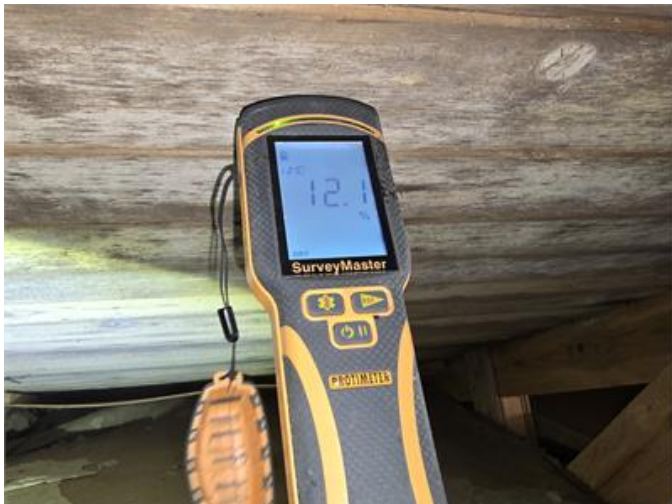
Nockvind: Mikrobiell påväxt/missfärgningar på underlagstak, fuktkvotsmätning utförd utan anmärkning.
