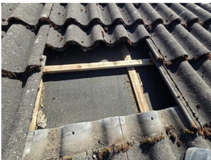
Tak: Stickprovskontroll under pannor på äldre del, tunn ströläkt med fuktanvisning noteras lokalt.
