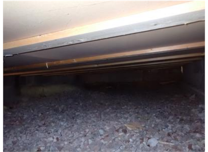
Vy över kryppgrund via ventil.
