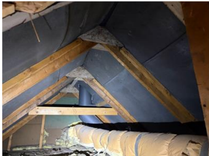
Allmän bild från vindsutrymmet
