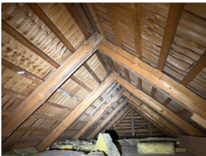
Allmän bild från vindsutrymmet
