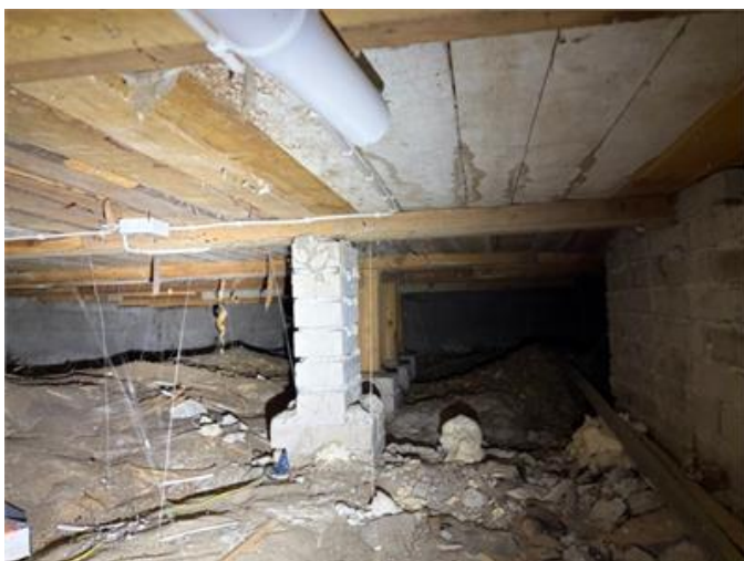
I utrymmet avslutas avluftningen från centraldammsugaren. Missfärgningar förekommer lokalt på undersidan av bjälklaget. Ingen förhöjd fukt uppmättes vid besiktningen.
