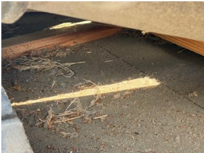
Stickprovskontroll av läkt och takpapp utförd utan anmärkning.
