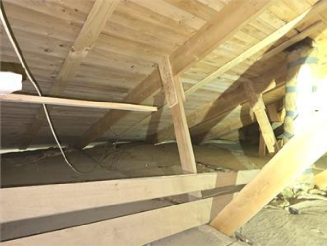
Överblick del av vinden.
