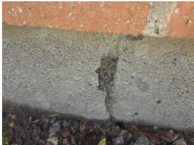
Putssläpp på grundsockeln.
