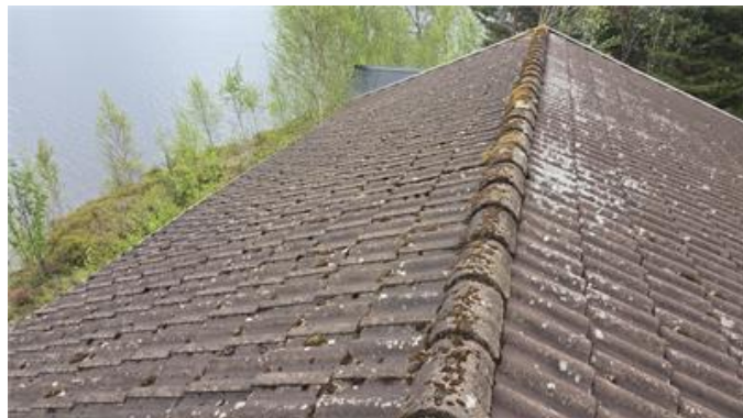
Översiktsbild, del av yttertak.
