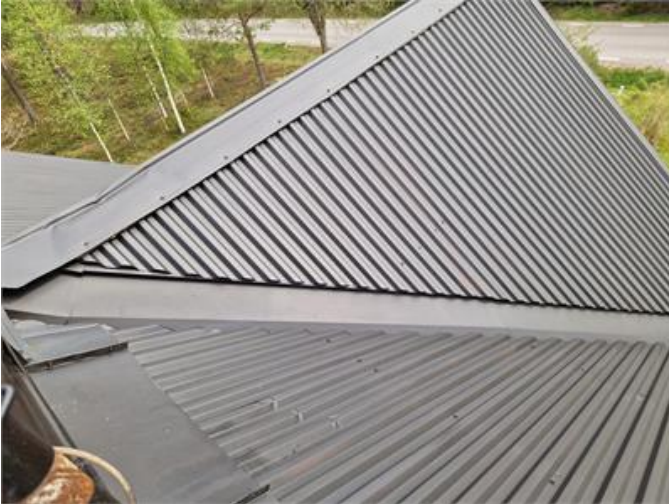
Vy på yttertak
