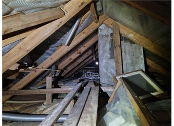
Vy på vindsutrymmet
