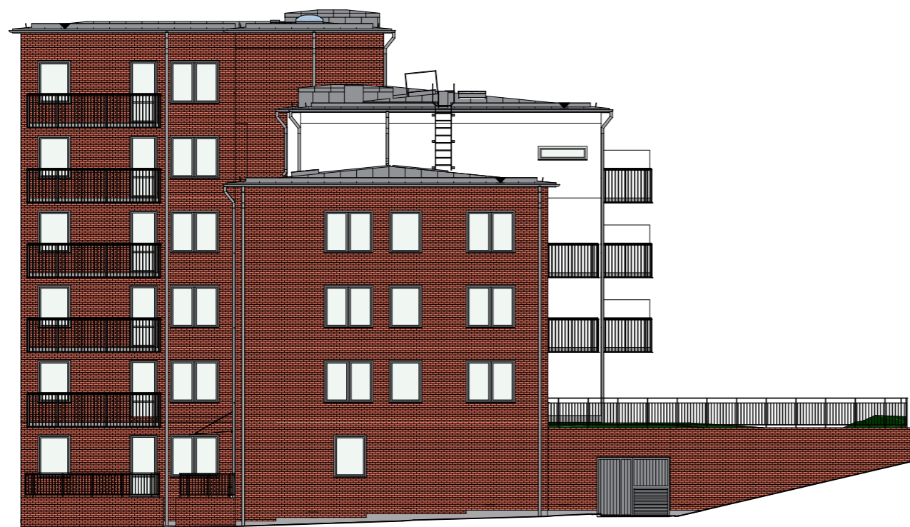
Trapphus 3, mot väster
