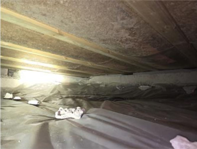
Bilden visar mikrobiell påväxt på blindbotten.
