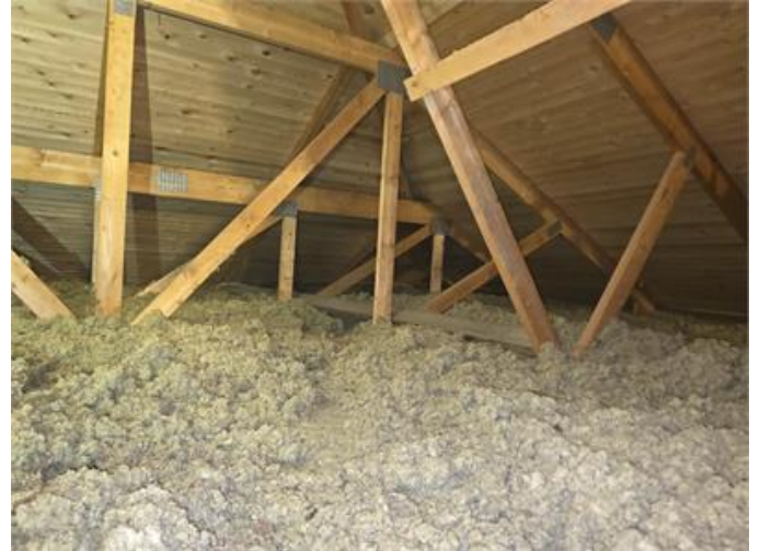
Överblick del av vinden.
