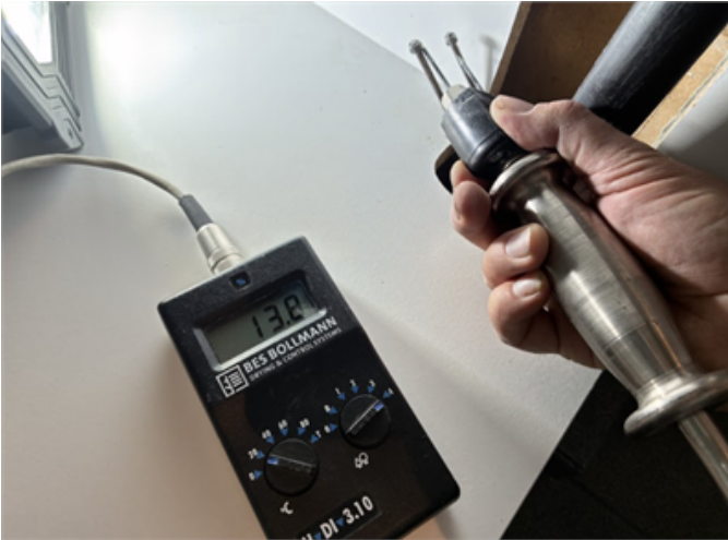
Bilden visar fuktkvotsmätning i innerväggsyll i tvätt, gränsvärde 17%FK.
