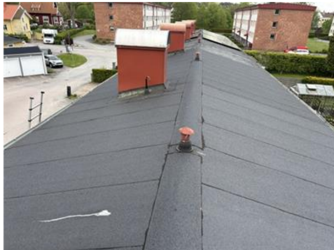
Bilden visar vy av tak (huvudbyggnad).
