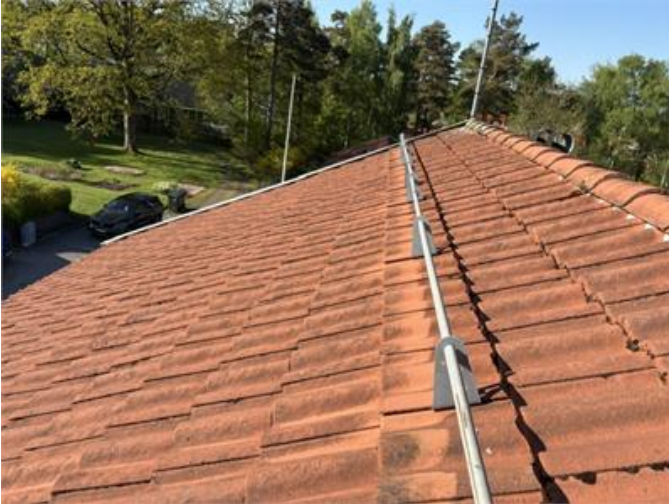
Bilden visar vy av tak (huvudbyggnad).
