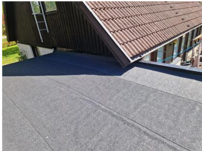
Vy på yttertak
