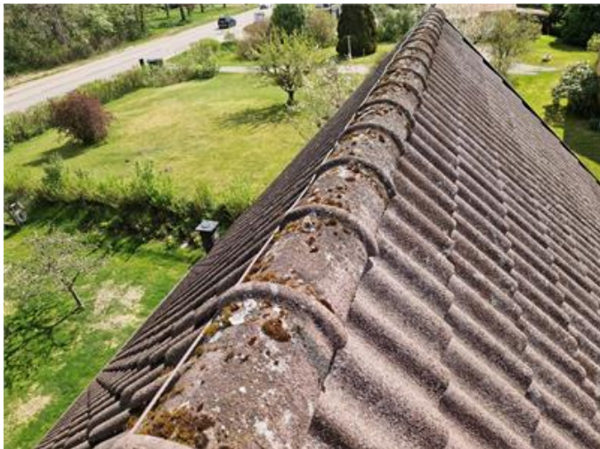
Vy på yttertak
