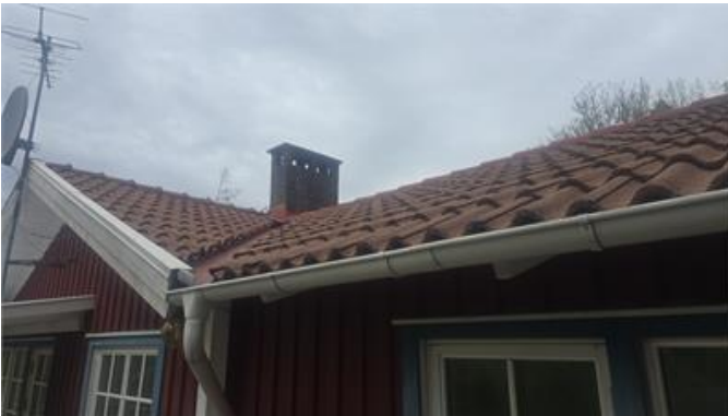
Översiktsbild, del av yttertak.
