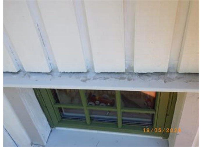
Plåtar är delvis monterade utanpå fasad.
