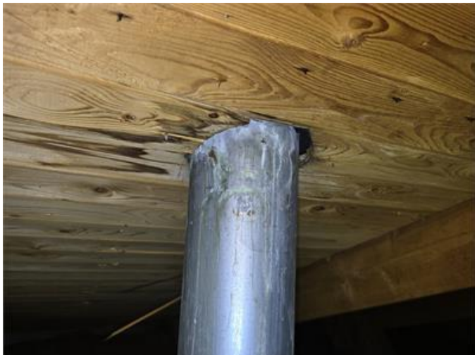
Nockvind: Fuktanvisningar kring genomföringar.
