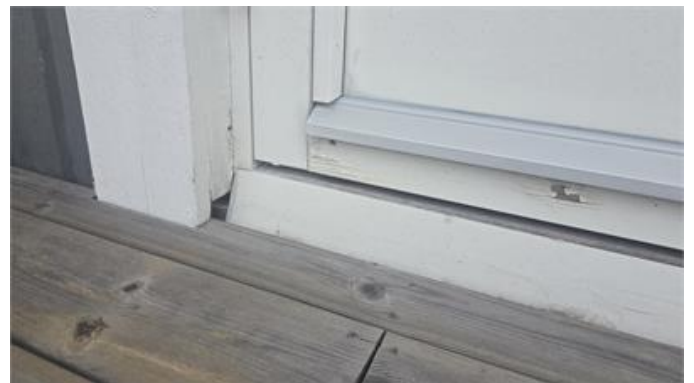
Exempelbild, målning/underhållsbehov altandörr och otätheter kring tröskelbleck.
