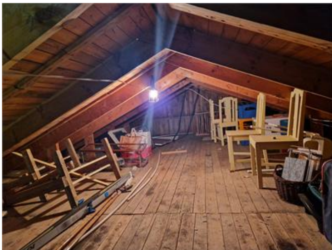
Vy på vindsutrymmet
