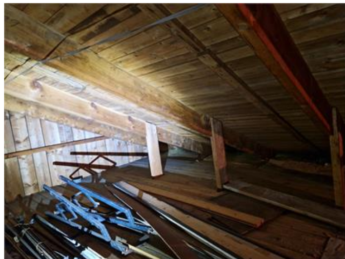
Vy på vindsutrymmet
