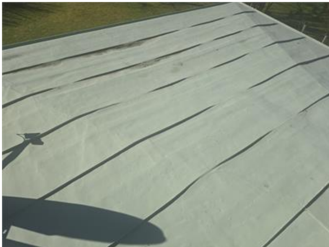
Överblick del av plåttaket.
