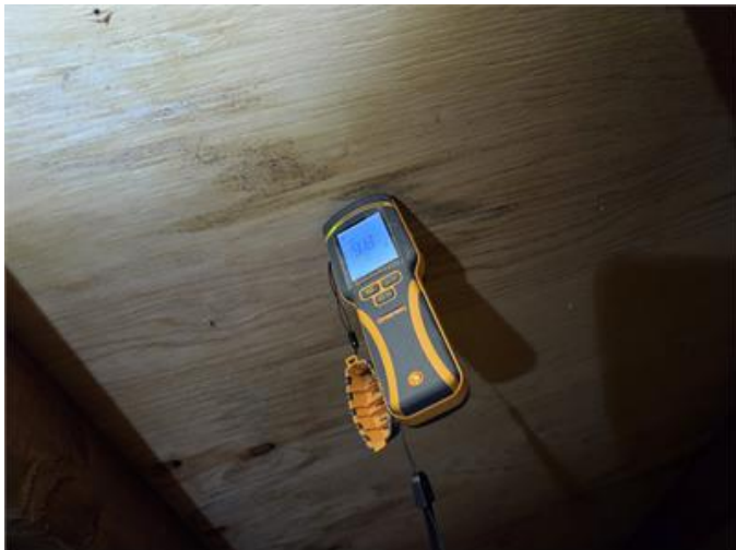
Bild från vindsutrymmet.
