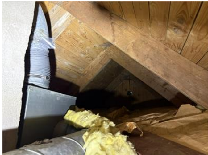
Bilden visar vy av vind.
