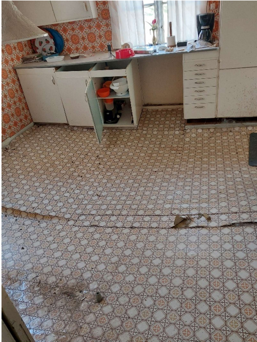
Bjälklag i kök
