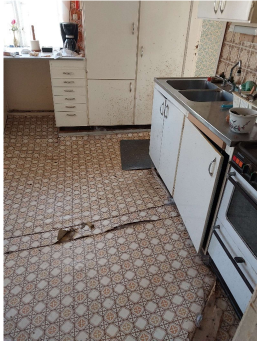
Bjälklag i kök
