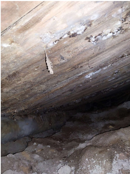
Undersida bjälklag i kök
