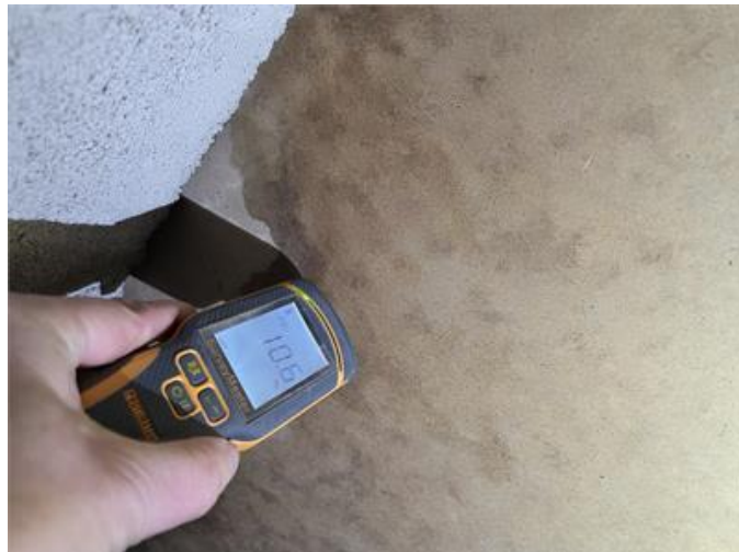
Bild från krypgrunden (ca under tvättstuga).
