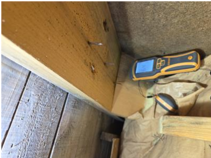
Bild från vindsutrymmet.
