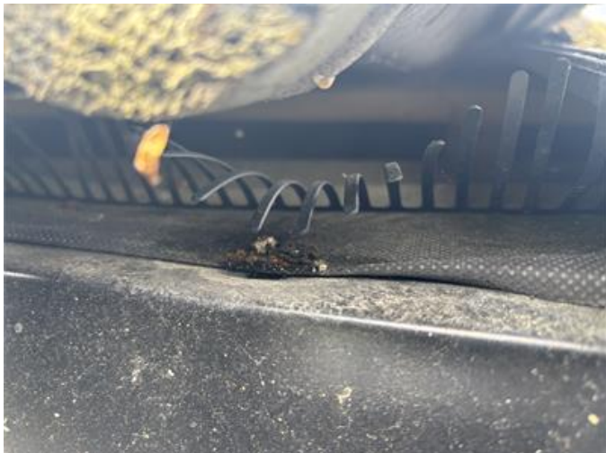
Stickprovskontroll av läkt och papp under betongpannor, utan anmärkning.
