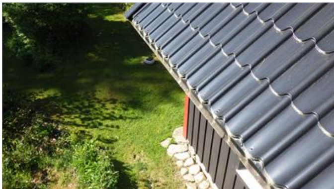
Bild på taket där det inte finns någon hängränna
