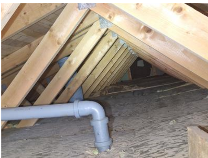
Nockvind, bild från lucka väster.
