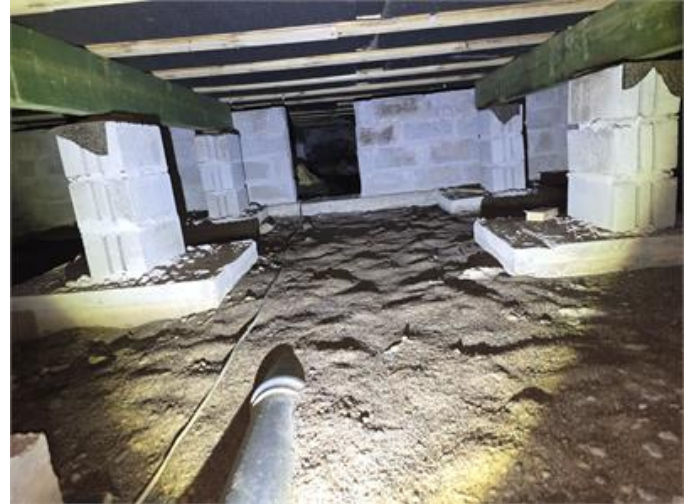
Krypgrund: Översiktsbild i Krypgrund mot norr.
