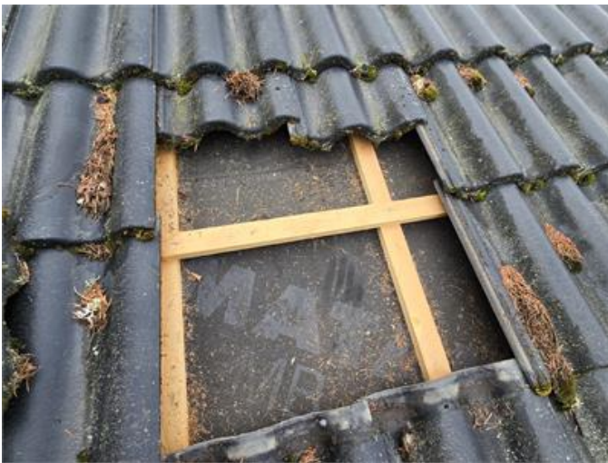
Tak: Stickprovskontroll under pannor på tillbyggnad.
