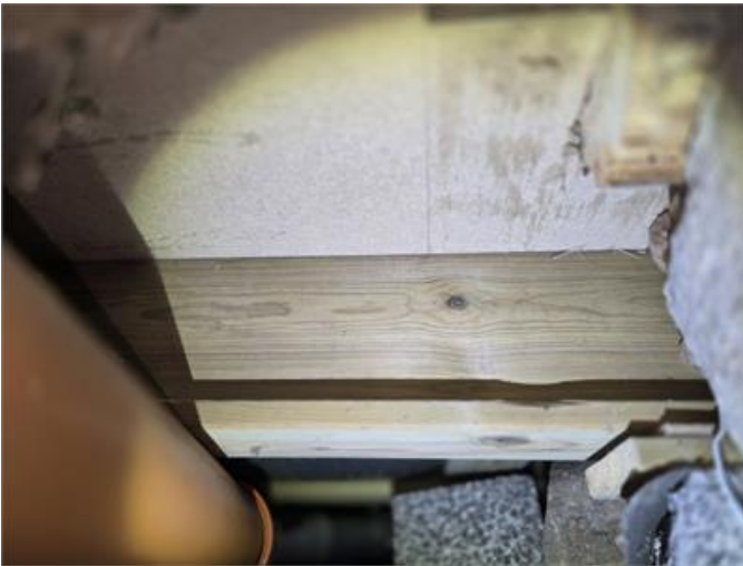
Krypgrund: Röttskyddsbehandlat virke förekommer, t ex i bjälklag under Wc/Tvätt.
