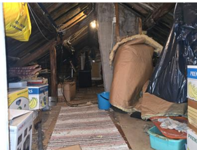
Nockvind ursprungshus: Översiktsbild.
