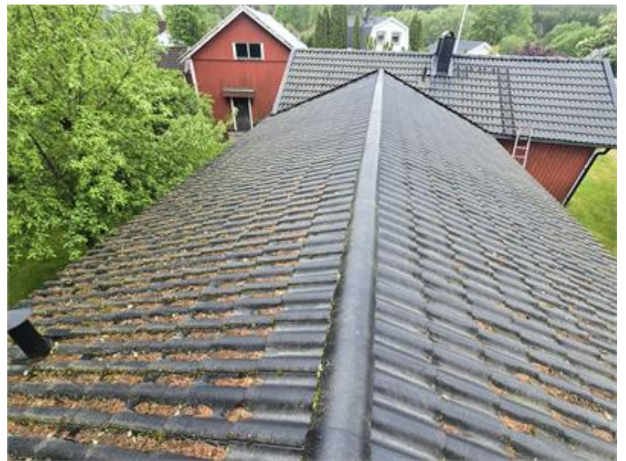
Tak: Översiktsbild, mycket löv/barr etc på pannorna.
