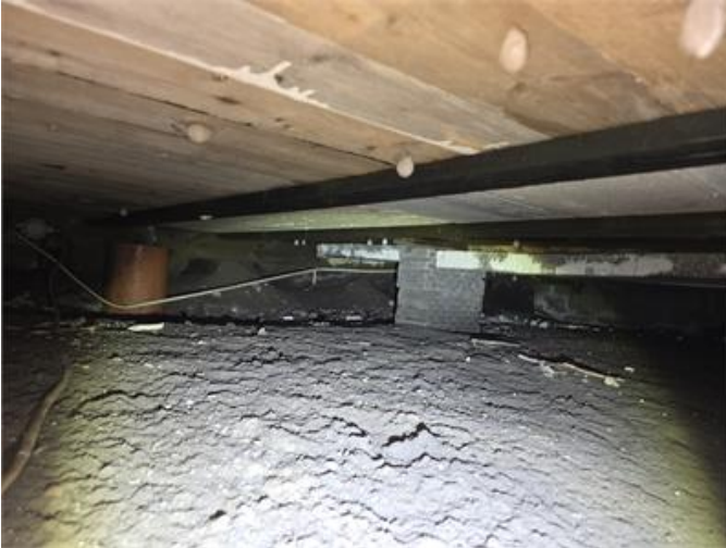
Krypgrund: Översiktsbild i Krypgrund mot söder.
