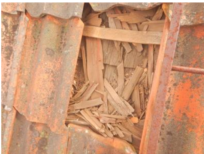
Pärt under takpannor
