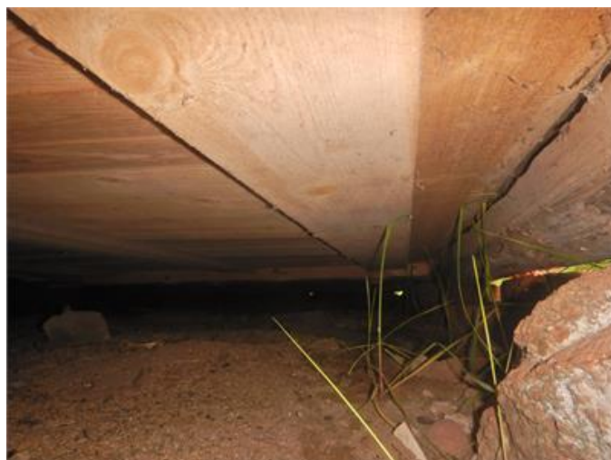
Undersida bjälklag från springa i grundmur.
