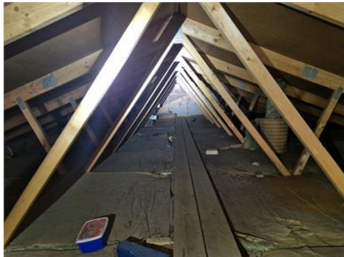
Vy på underlagstak/vindsutrymmet
