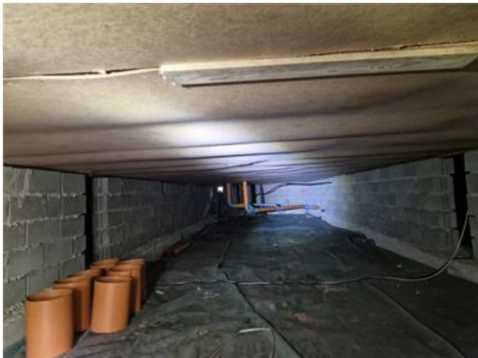
Vy i krypgrund
