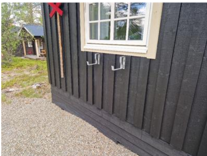
Fasad och fönster.
