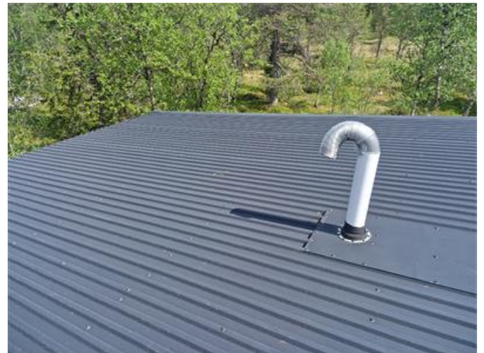
Delar av tak är låglutande.
