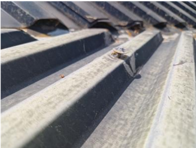
Äldre infästningar kryper.
