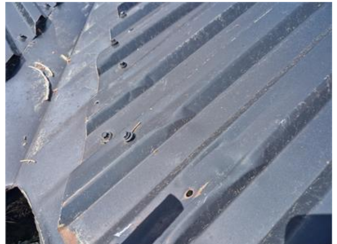
Enstaka hål och otätheter förekommer.
